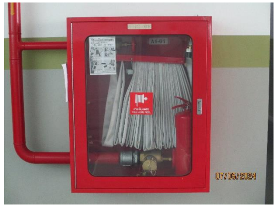
รูปที่ 3-30 ตู้เก็บสายฉีดน้ำดับเพลิง (Fire Hose Cabiner)
