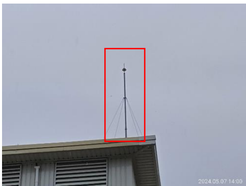
รูปที่ 2.5.9-11 เสาตัวนำล่อฟ้า
