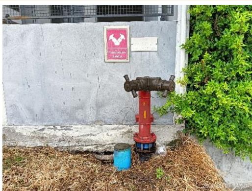
รูปที่ 2.5.2-1 หัวจ่ายน้ำดับเพลิง (Hydrant)
