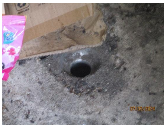
รูปที่ 3-20 ท่อระบายน้ำเสียจากการชะล้างห้องพักมูลฝอย
