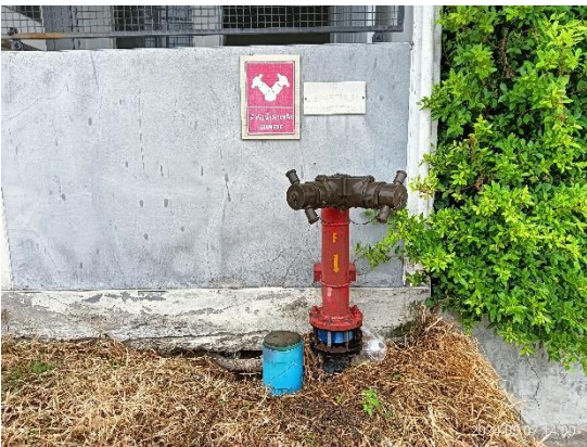
รูปที่ 3-29 ท่อรับน้ำดับเพลิง
