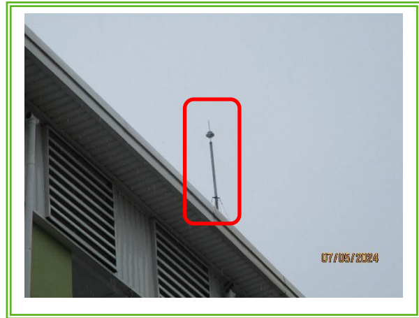
รูปที่ 3-34 เสาตัวนำล่อฟ้าบริเวณชั้นดาดฟ้าของโครงการ
