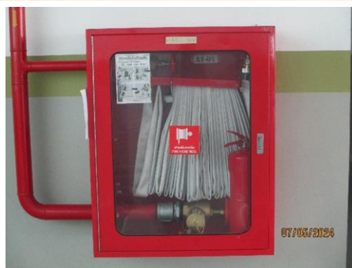
รูปที่ 2.5.2-2 ตู้เก็บสายฉีดน้ำดับเพลิง
